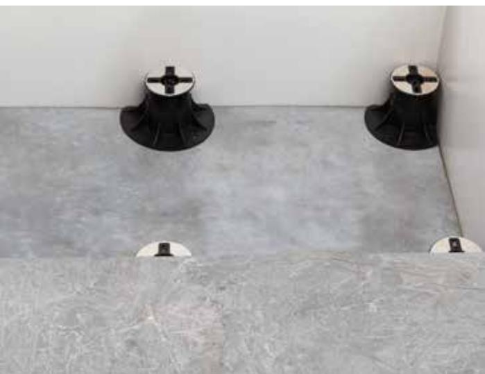
AL FINE DI DISTRIBUIRE NEL MODO PIÙ OMOGENEO I CARICHI, SI RACCOMANDA NELL'UTILIZZO DEL 60X60 - 80X80 L'INSERIMENTO DI UN SUPPORTO CENTRALE ALLA LASTRA RIMUOVENDO LE 4 ALETTE DISTANZIATRICI PRESENTI SULLA SOMMITÀ DEL SUPPORTO (IN CASO DI UTILIZZO DI SUPPORTI REGOLABILI O REGOLABILI/AUTOLIVELLANTI).
